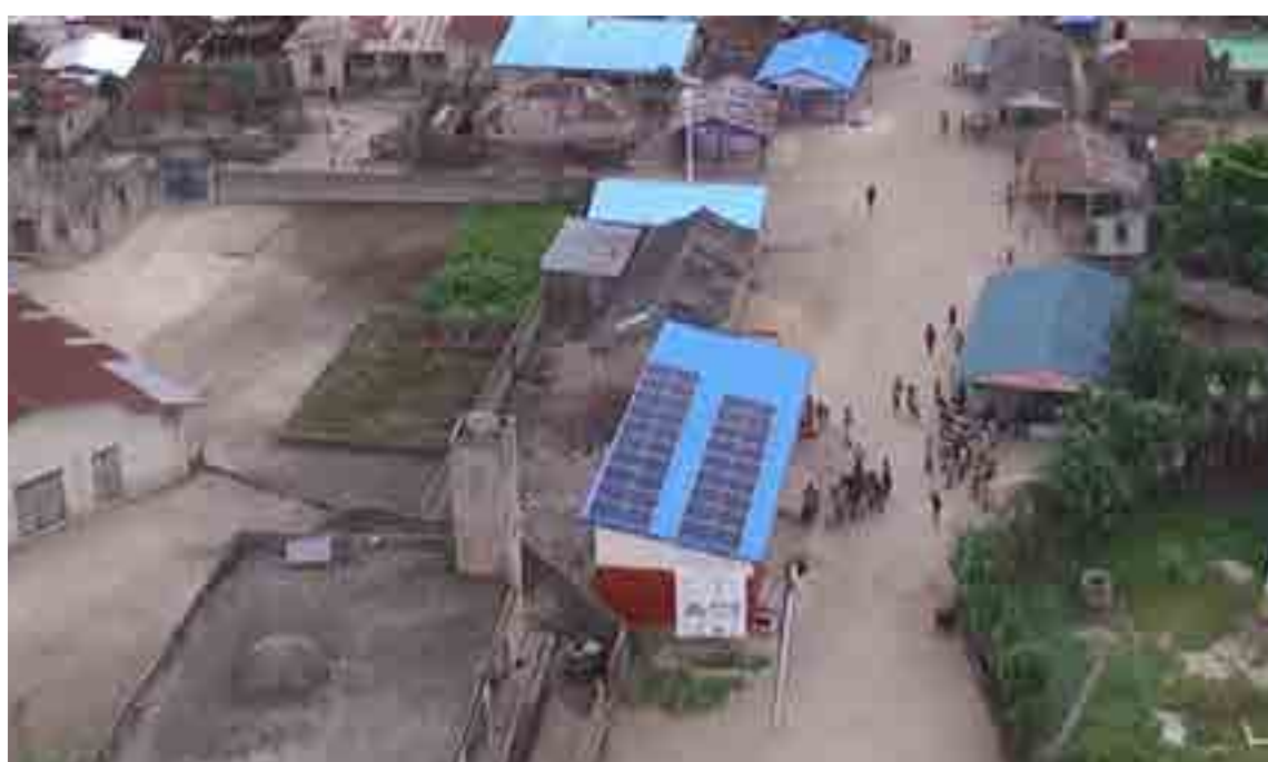
Supervision du café lumière (mini-réseau) de Hounhouè - Commune de Dangbo (Promoteur ESF - Électriciens Sans Frontières)
