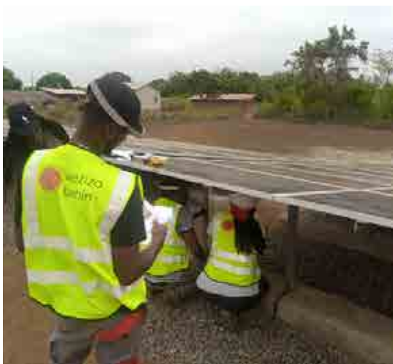
Inspection du mini-réseau de Takpatchiomé - Commune de Aplahoué (Promoteur Energicity, projet Wéziza Bénin)
