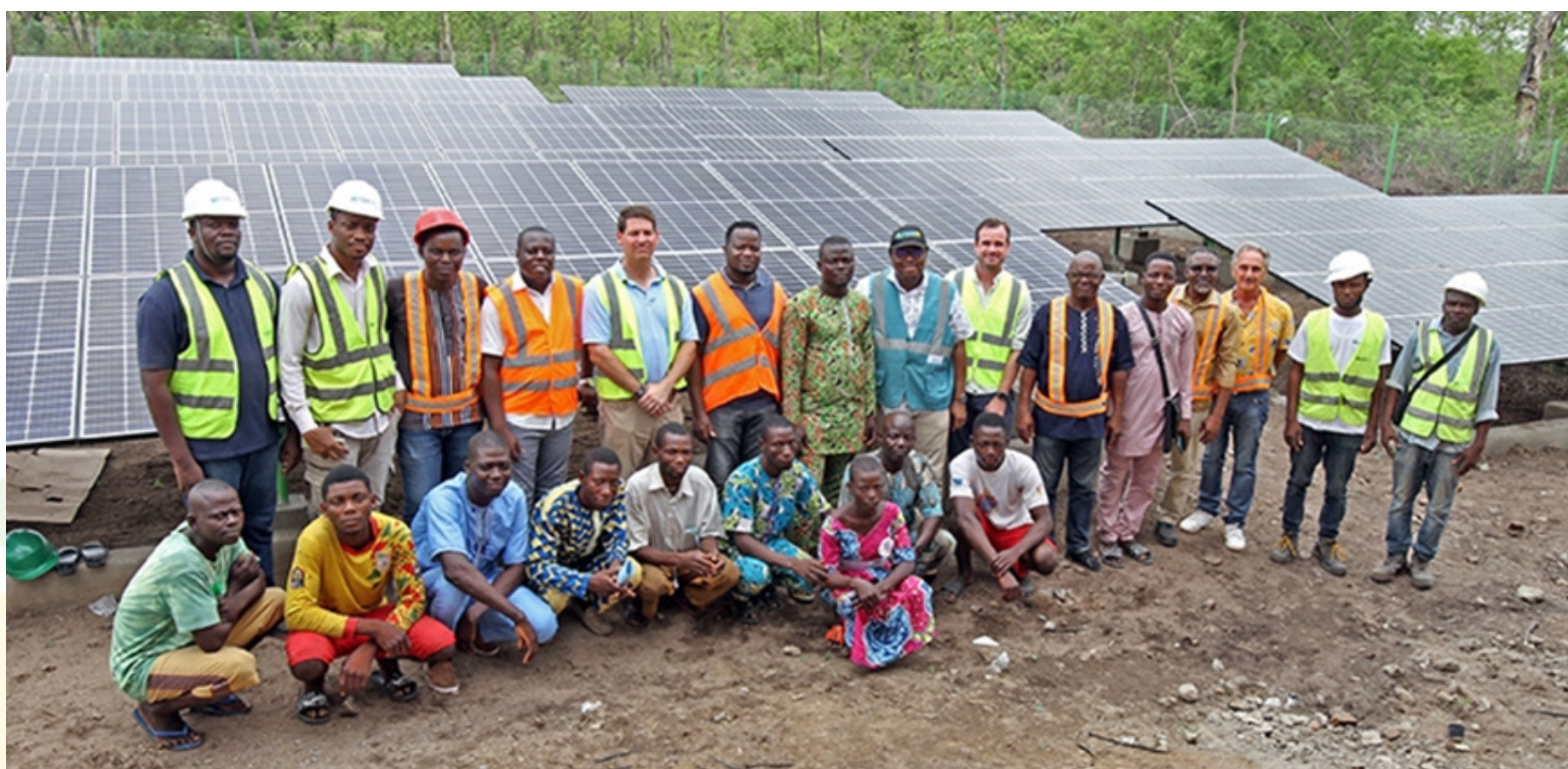
Mini-réseau- Commune de Djabata Mai 2022 (Promoteur ASEMI)
